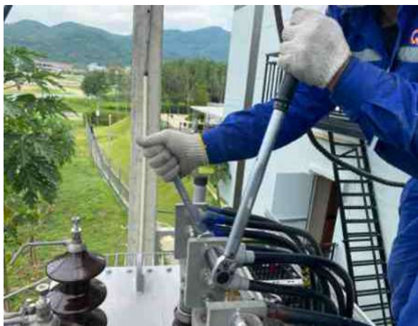
ชั้นอัดชั่วคราวสายไฟฟ้าด้านแรงต่ำ
