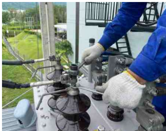
ชั้นอัดชั่วคราวสายไฟฟ้าด้านแรงสูง
